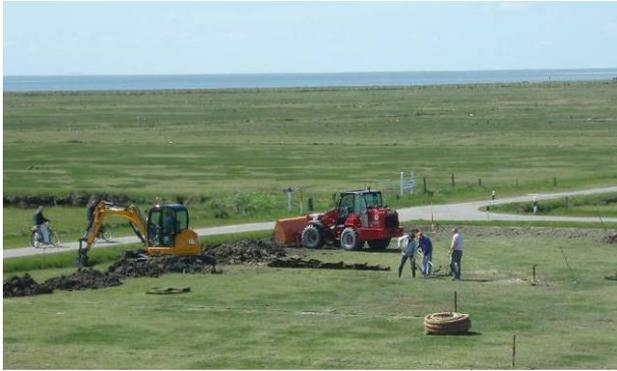
**Abb. 35:** Aufschüttung des Walls in Versuchsfeld B und verlegen der Drainage im Mai 2010.
