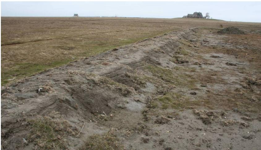
**Abb. 55:** Beschädigter Wall im Versuchsfeld A (Hooge) im März 2011
