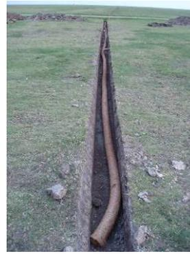
**Abb. 36:** Drainagerohre im offenen Graben.
