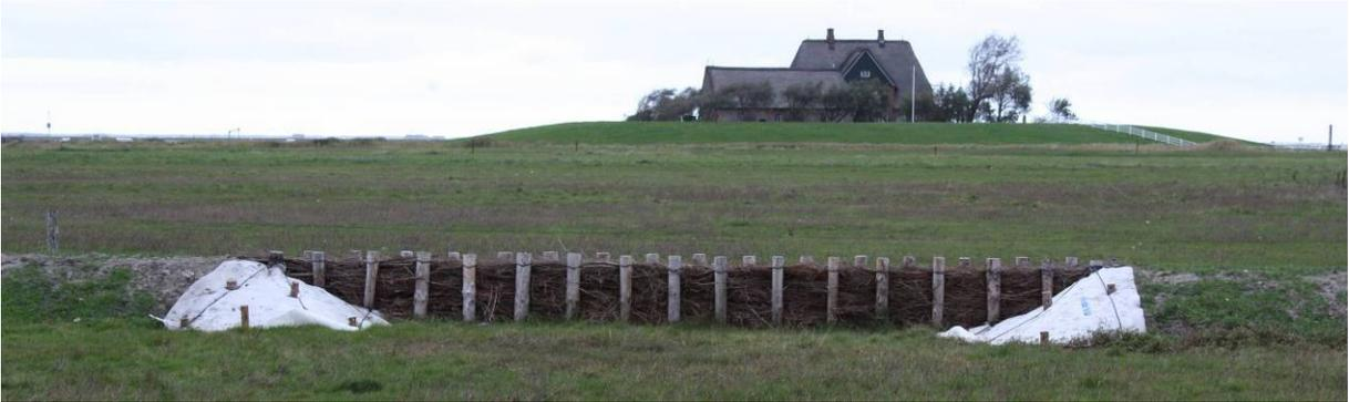
**Abb. 29:** Oberirdischer Durchlass zur Entwässerung der umwallten Maßnahmenfläche im September 2010
