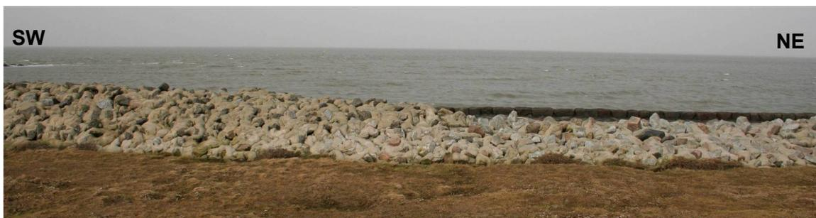
**Abb. 63:** Unterschiedliche Deckwerkshöhen am Westufer von Nordmarsch im Bereich der Anomalie von **Abb. 62**. Der linke Deckwerksabschnitt ist ca. 60cm als höher als der rechts angrenzende
