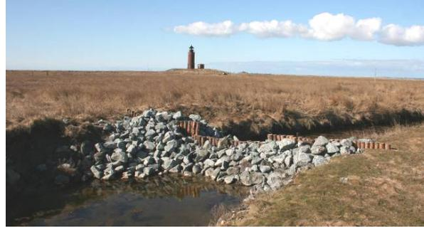
**Abb. 41:** Erhöhte Steinbarriere mit interner Pfostenreihe seit Januar 2011.
